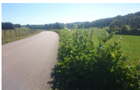
Invasion de Renouées à la suite des travaux de terrassement en bordure de route départementale.
