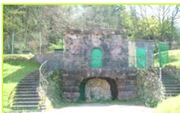
Réservoir d'eau potable de la Vierge à Epinal © Aurélie WOJCIECHOWSKI
